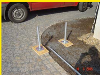
Obr. 1.: Základ lešení s využitím podkladové fošny, délka vytočení vřetene
